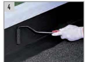
4 Después de 2 - 5 h aplicar la segunda capa de ALSAN FLASHING de 0.7 kg/m 2 sobre la primera capa.
