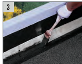
3 Aplicar una primera capa de ALSAN FLASHING de 0.9 kg/m 2 sobre el ALSAN ARMATURE.
